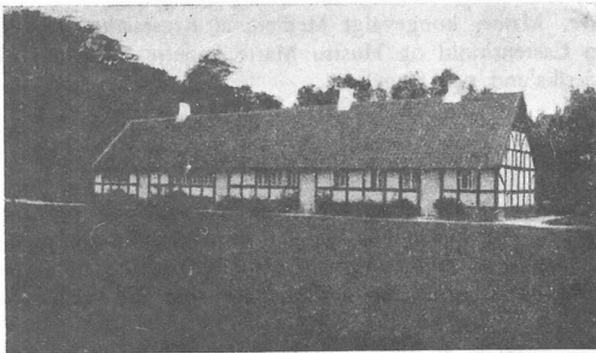
Rester af de gamle Huse paa Gyllingnæs.
