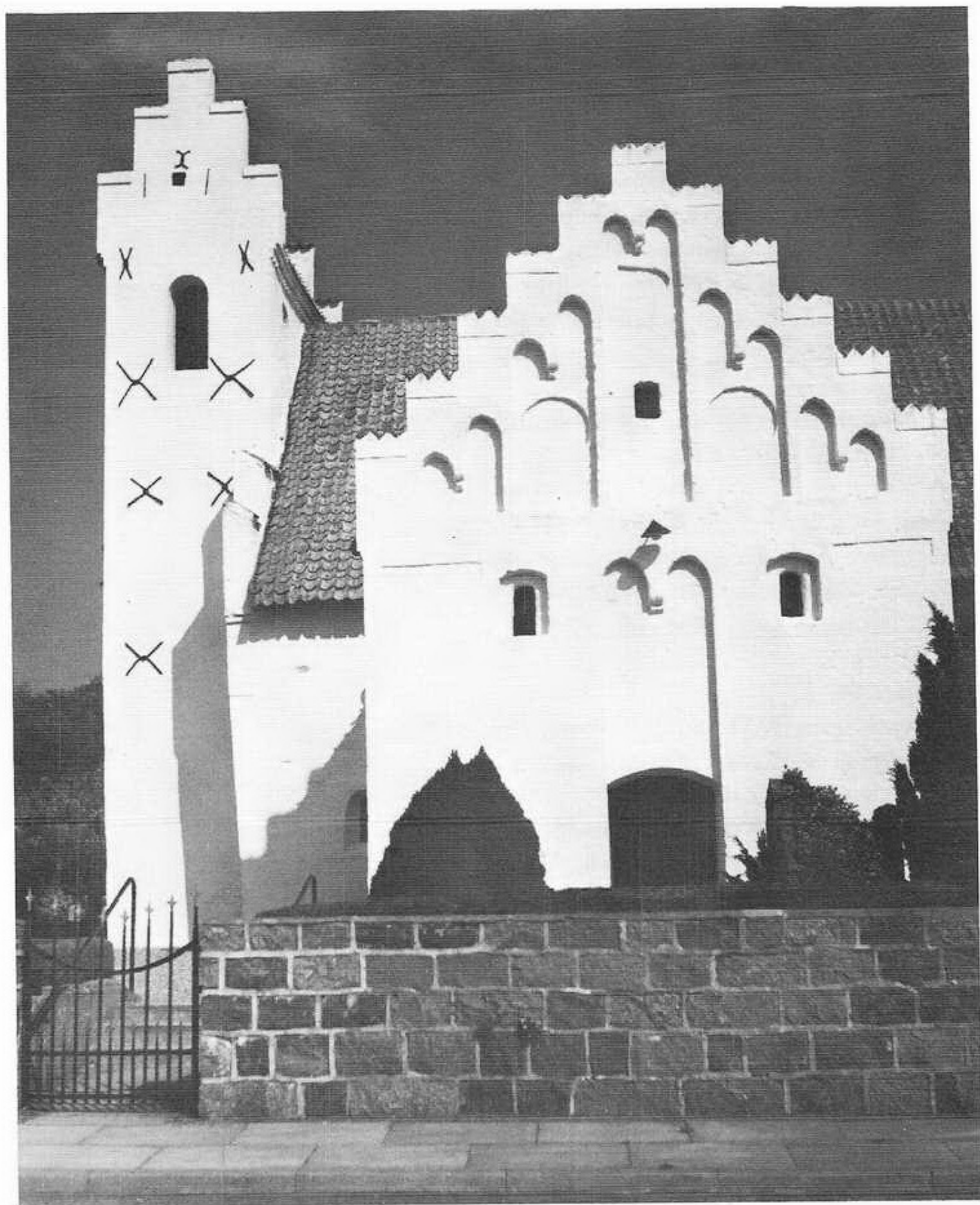
Tårn og våbenhus på Gylling Kirke
